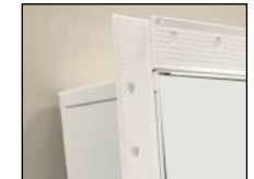
Drywall Bead Flange
